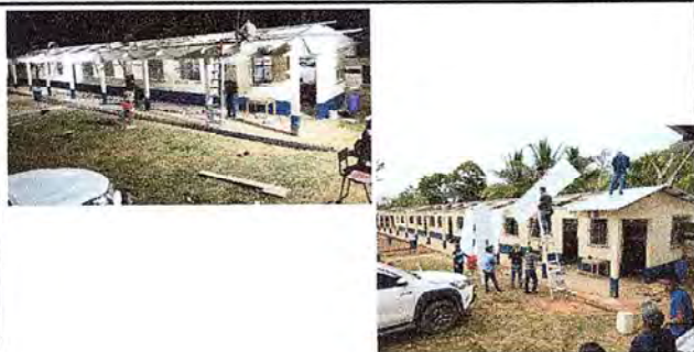
Foto1: Se hizo el cambio del techo de la escuela de 5 aula
