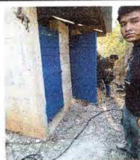
Foto 6: Se hizo la colocacion de las tres puertas de letrino de mal estado de lado izquierda, de areglo de 3 puertas de baños.
