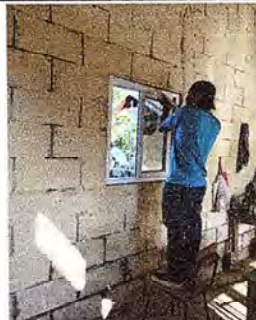
Foto 4: Se hizo la colocacion de la ventana del aula de preprimaria, la medicion es 86 x 2 mts.
