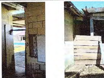
Foto 2: construccion de dos puertas con la medida es 86x 2 mts.
